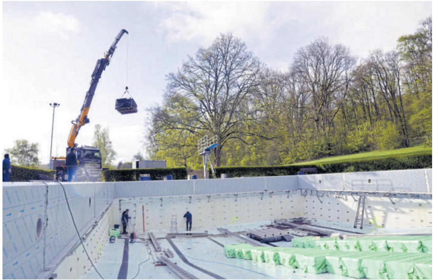
Zuletzt wurden große Stahlbauteile mit dem Kran angeliefert.
